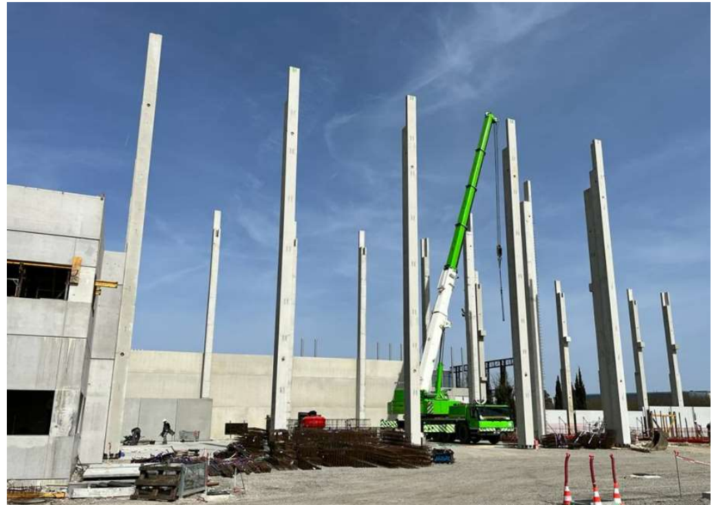
Chaudière Biomasse pour Airbus à Blagnac (31700) Poteau de 22mht sur 1 levé
